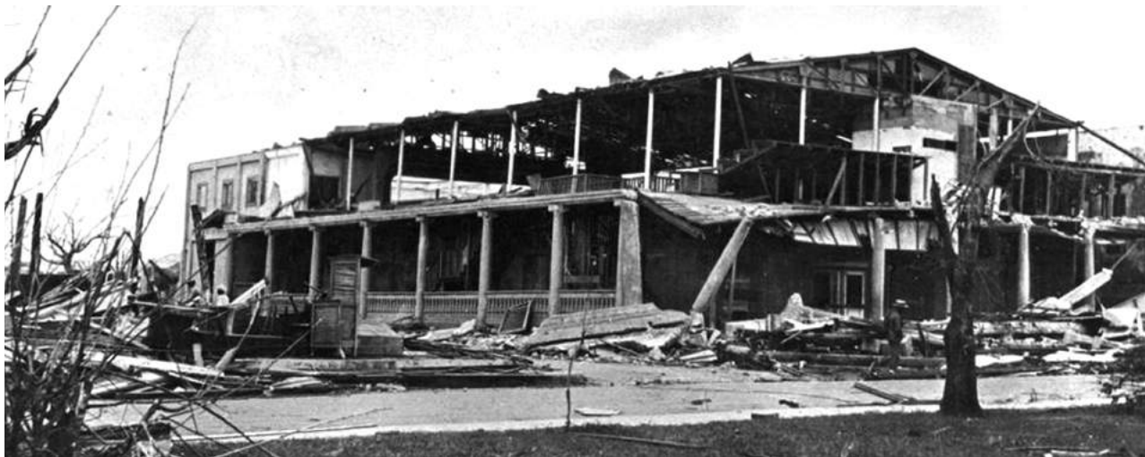
El Teatro Independencia, al igual que el Teatro Colón, sufre los embates del ciclón San Zenón tras su paso por la ciudad de Santo Domingo el 3 de septiembre de 1930. Su infraestructura queda seriamente afectada, aunque luego se reconstruye para seguir su operación. Fuente: Archivo General de la Nación (AGN).
